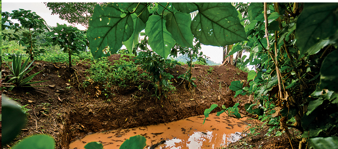
Fosa de infiltración
