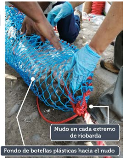
Figura 12. Se recomienda uso de guantes para socar el lazo de 1/8 y 1 pulgada Fuente: MARN, 2019
