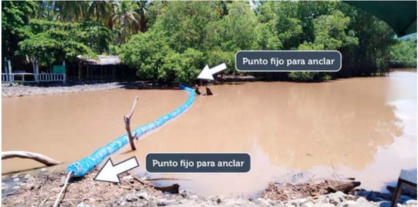
Figura 13. Rióbarda instalada en el municipio de Tamanique, departamento de la Libertad. Fuente: MARN, 2019
