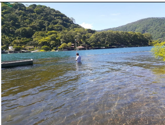
Levantamiento topo-batimétrico en zonas complementarias (aguas someras)
