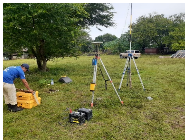
Imagen 9. Instalación de Base Trimble SPS855.
