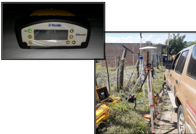
Imagen 7. Instalación de Base Trimble SPS855.
