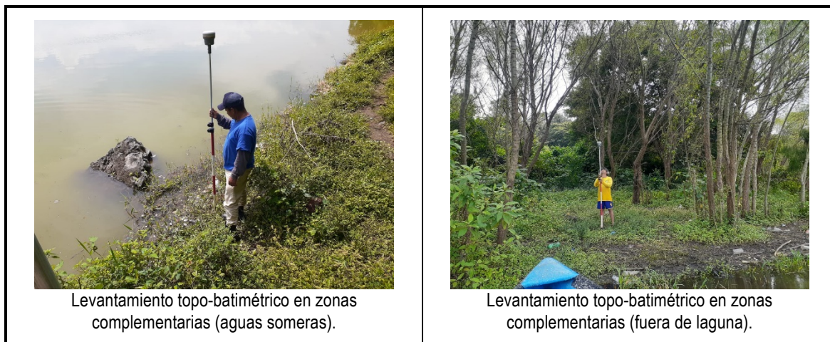
Imagen 47. Levantamiento topo-batimétrico en zonas perimetrales de laguna, sin cobertura con equipo Monoház.
