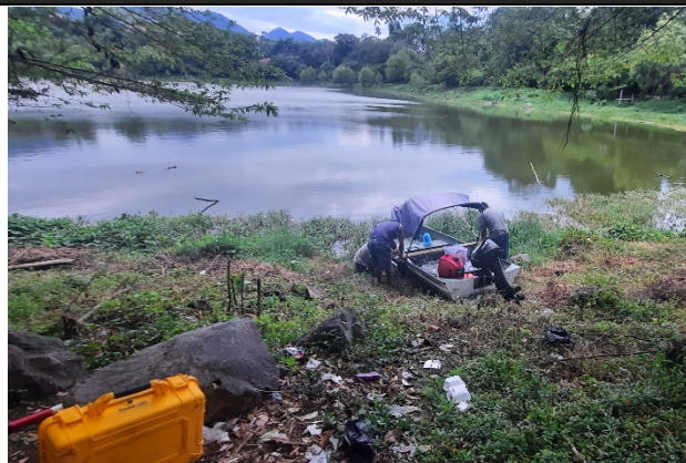
Instalación de equipo hidrográfico en embarcación.
