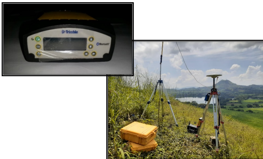
Imagen 28. Instalación de Base Trimble SPS855.
